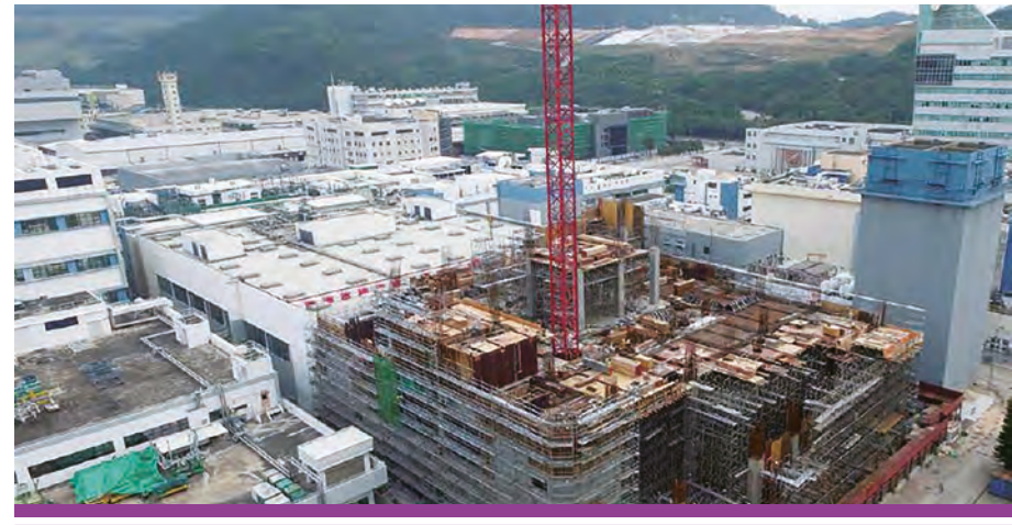
正在建設的六期廠房的鳥瞰圖（拍攝於 2016 年年底）。
